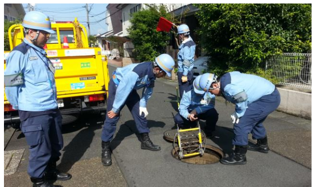
【参考】下水道管の被害調査の様子
