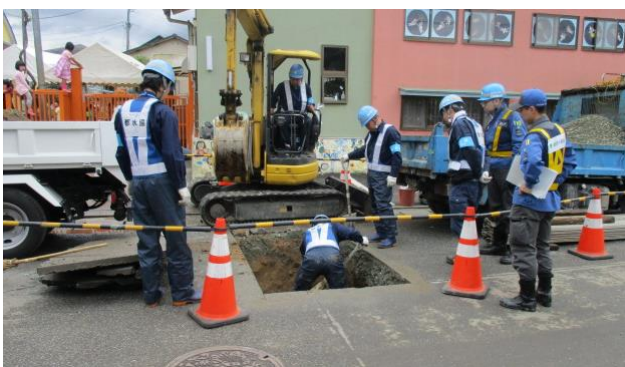
【参考】熊本市漏水補修工事の様子
