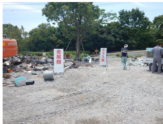
【参考】一次仮置場の様子（分別の誘導）
