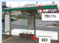
バス停留所に設置された太陽光発電設備
