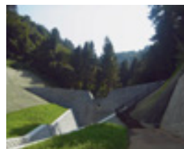
土砂流対策 (砂防堰堤)
