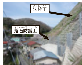
急傾斜地対策
