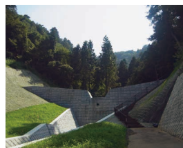
土石流対策(砂防堰堤)
