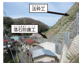
急傾斜地対策
