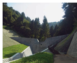
どせきりゅうたいさく さほうえんてい 土石流対策(砂防堰堤)
