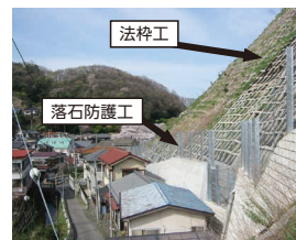
急傾斜地対策
