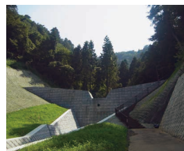
土石流対策(砂防堰堤)
