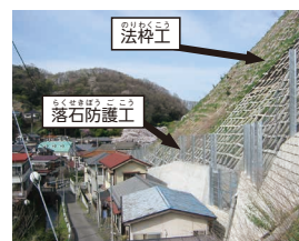
急傾斜地対策
