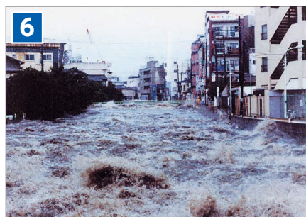
昭和56年7月豪雨 神田川(新宿区) 浸水被害: 13,662棟
