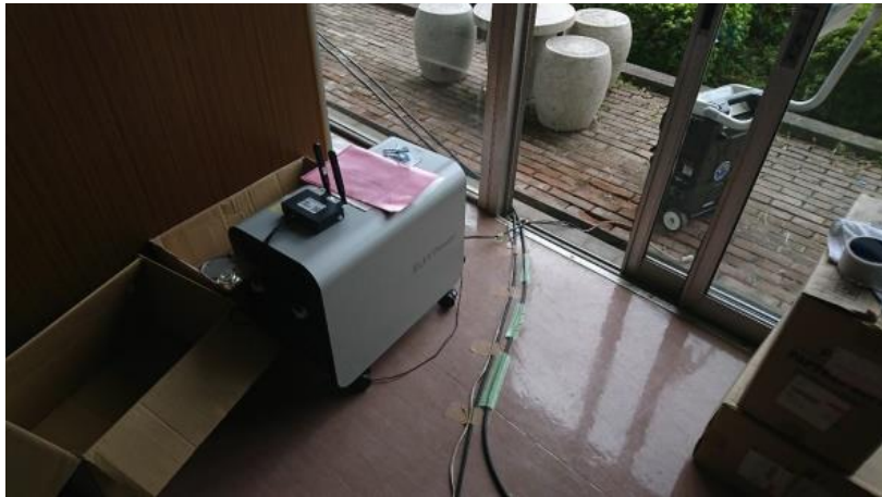
カセットボンベ発電機(清和公民館)
