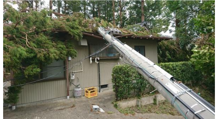
倒れた電柱が直撃した建物(秋元小学校)
