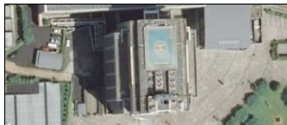
屋上ヘリポート(H)の例(足立区役所)
