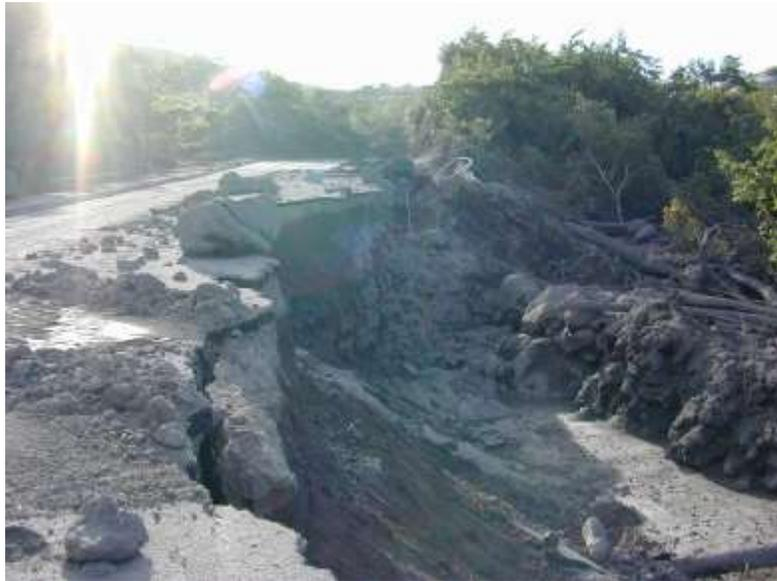
泥流被害による道路の崩落
