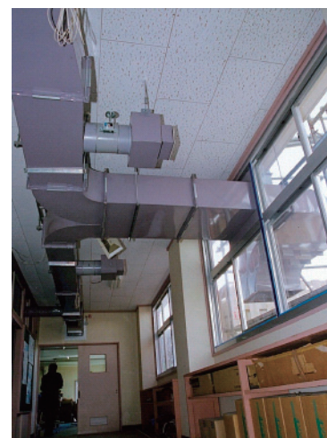
三宅中学校の脱硫装置
