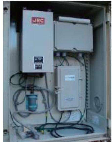
釜の尻沢のワイヤセンサー設置状況(左)とワイヤ局(右)
