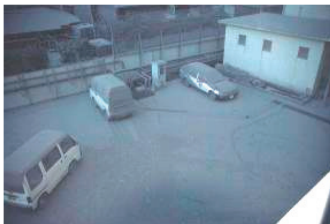
発電所構内に降り積もった火山灰
