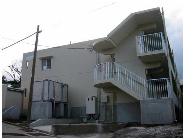
完成した村営住宅（神着）
