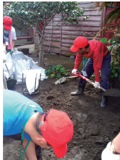
降灰除去作業
