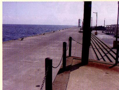
地殻変動に伴う沈下により港湾・漁港施設が波をかぶりやすくなったため、災害復旧の活動拠点となる三池港及び阿古漁港の大型定期船岸壁のかさ高上げを実施しました。また、三池港・伊ヶ谷漁港においては岸壁の延伸を行い三池港は岸壁延長150mが完成しました。今後は、伊ヶ谷漁港の大型定期船避難岸壁を25m延伸し、16年度に岸壁延長150mを完成させ、坪田漁港や伊ヶ谷漁港の沈下施設のかさ高上げ等の復旧作業を進めていく予定です。
