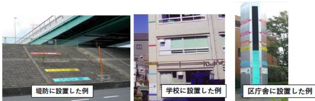
図表 59 浸水深表示板の設置例（東京都江戸川区）
