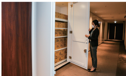
廊下の壁面が防災倉庫となっている
