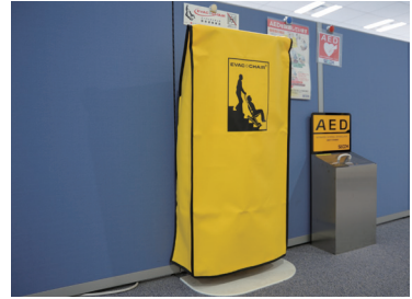
エレベーター前に、歩行困難者の階段避難器具を設置
