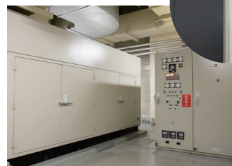
重油で約4時間稼動する非常用発電機を配備
