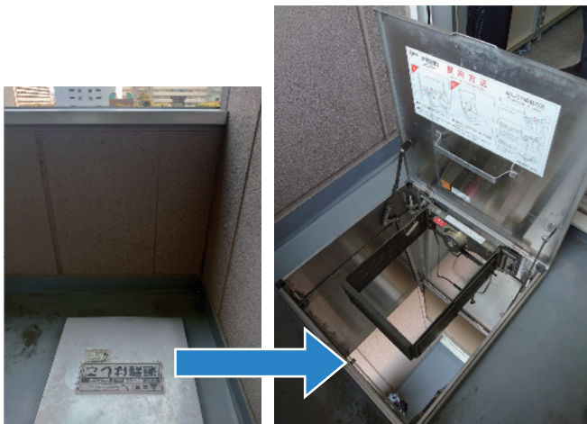
実際に使用すると揺れてスムーズ降ることができない 避難はしごでの昇降は普段から慣れることが重要
