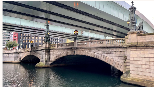
日本橋川：首都高速道路が日本橋川上空を走る日本橋川、近年では景観等の観点から見直され、現在地下化工事が進められている。またそれに伴い周辺の再開発も行われている。
