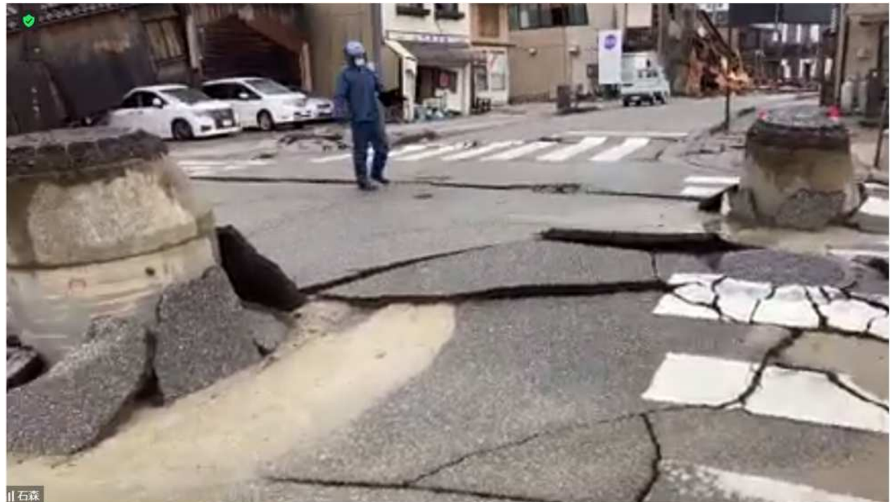
液状化により浮上したマンホール（輪島市内）
