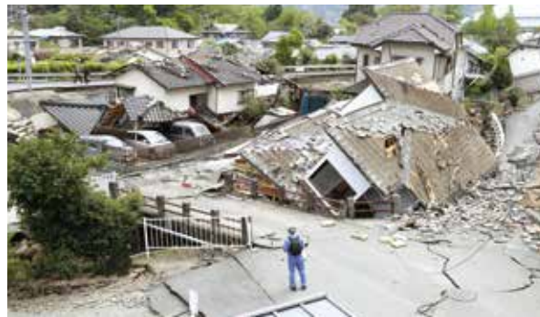
熊本县益城町寺迫地区的大量房屋因剧烈摇晃而倒塌 [照片提供 / 共同通讯社]
