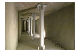
経年防火水槽の再生工事
