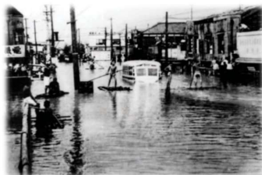
葛飾区本田四ツ木町浸水状況
