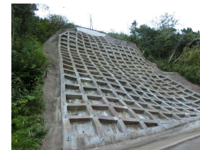
斜面对策の事例 (八丈循環線)
