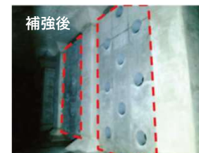
配水池の耐震化 (耐震壁の新設)
