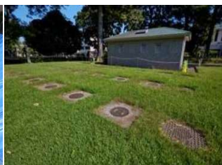
マンホールトイレ
