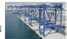
耐震強化岸壁・免震クレーン
