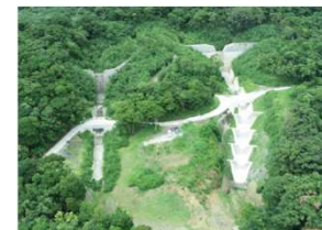
火山砂防施設 (三宅島筑ヶ沢)
