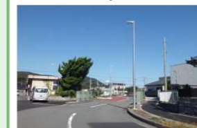
大島差木地区の無電柱化 (上：整備前 下：整備後)
