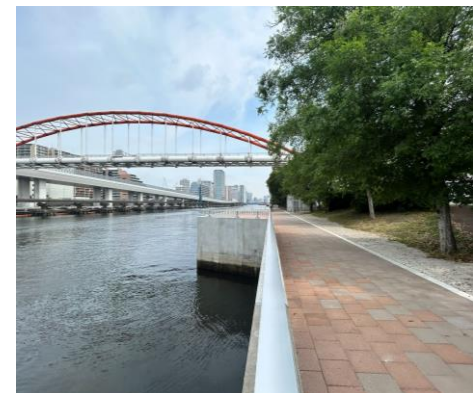
東京港海岸保全施設整備
