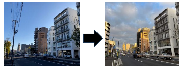
無電柱化整備事例 (左：整備前 右：整備後) 環七通り（北区神谷）
