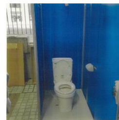
③マンホールトイレ
