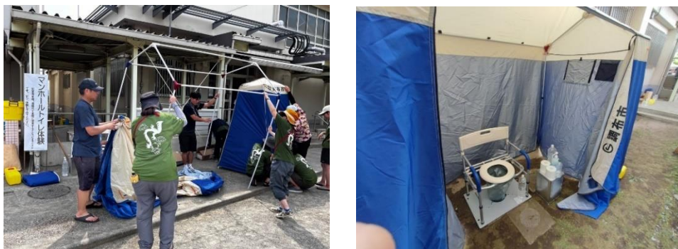
図-11 マンホールトイレ設置訓練
