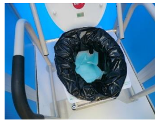
図-21 写真 し尿凝固型 ※「災害時こまらんトイレ！」の整備箇所以外で設置
