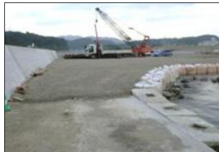
志津川漁港南防波堤復旧工事
