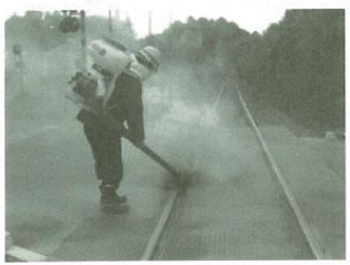
写真－6 灰の除去作業
