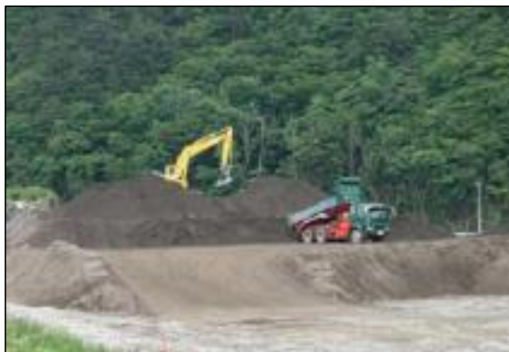
鵜住居地区スポーツレクリエーション拠点整備工事
