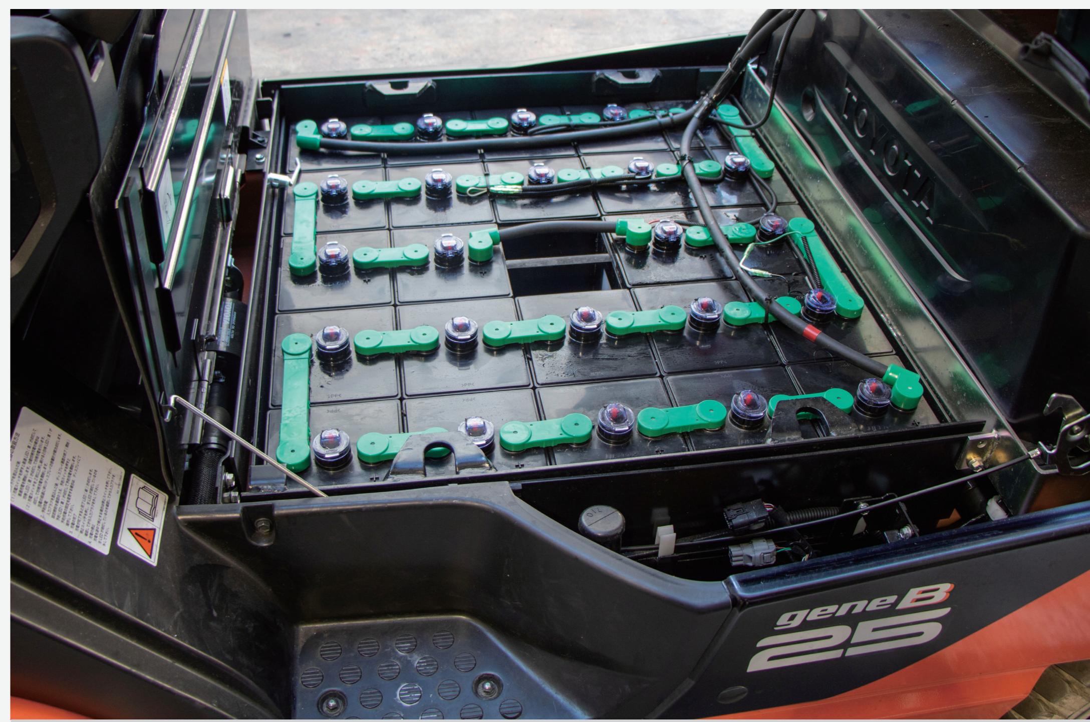
フォークリフトを活用した給電設備
