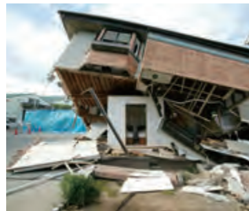
设置了抗震掩体的木制住宅遭遇地震后的倒塌情况
