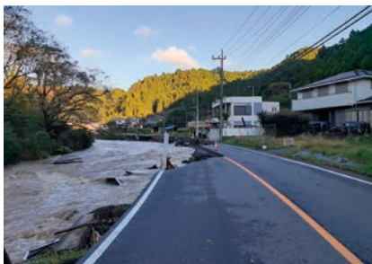
一般道道奥多摩秋留野线（第184号） 平井川左岸(日之出町)
