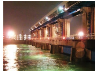
为应对高潮而关闭了的今井水闸
