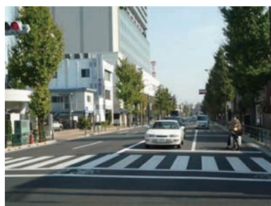
无电线杆化的整備事例 野猿街道（八王子市子安町） （上：整備前，下：整備后）
