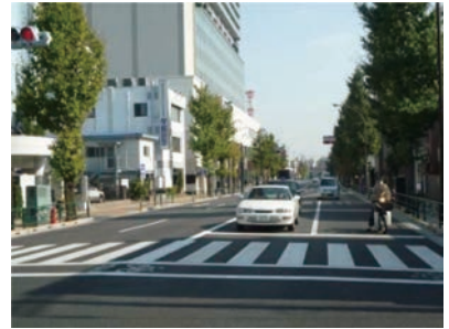
무전주화 정비 사례 야엔 가도 (하치오지시 코야스마치) (위 : 정비 전, 아래 : 정비 후)
