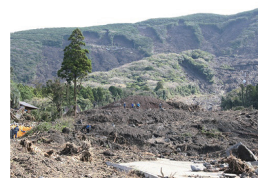
2013 年 台風第 26 号による伊豆大島の土砂災害
