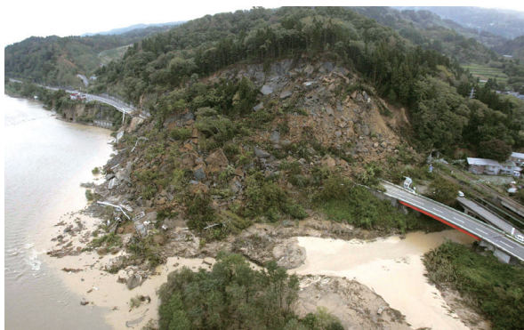
長岡市妙見町の県道で起きた大規模な土砂崩れ〔写真提供／共同通信社〕
