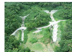
火山砂防施設 (三宅島筑ヶ沢)
