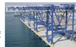
耐震強化岸壁・免震クレーン
