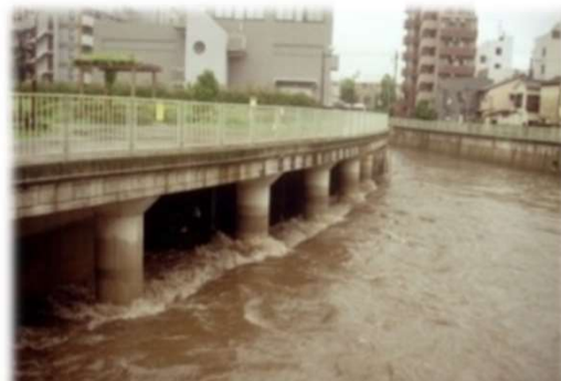
神田川・環状七号線地下調節池への流入（神田川取水施設）
