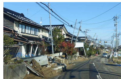
液状化被害の例
