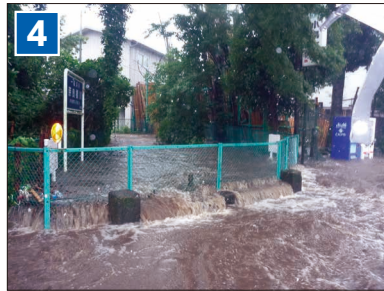
平成28年8月台風9号 奈良橋川(東大和市) 浸水被害: 403棟
