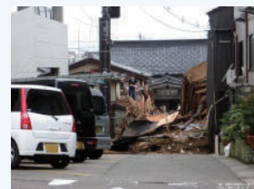
【出典】(一財)消防科学総合センター
