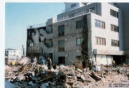
【出典】(一財)消防科学総合センター
