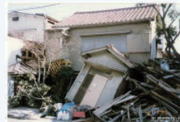
【出典】(一財)消防科学総合センター
