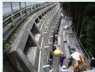
▲ 既設グラウンドアンカーの更新工事
