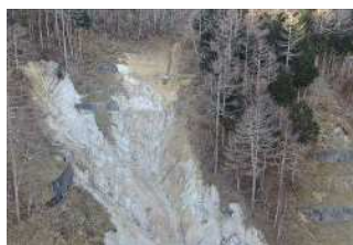
▲崩壊地の近景
