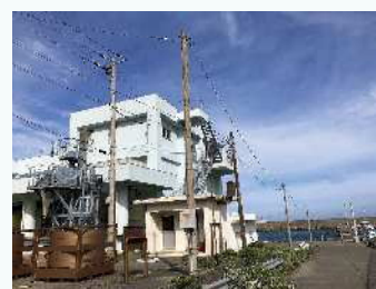
▲現状の新島港の状況
