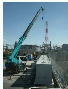
▲防火水槽の設置
